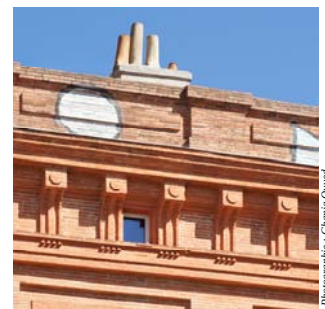
Corniche de l'immeuble Saget
