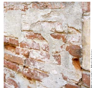
Mur blanchi à la chaux
